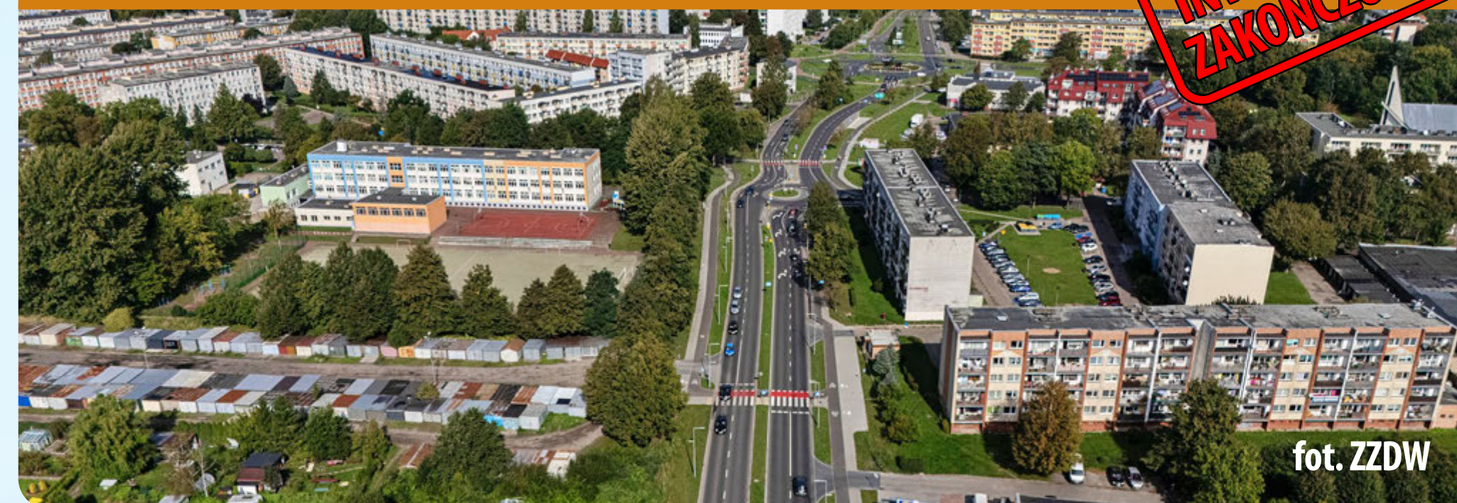
Rozbudowa DW 163 w m. Kołobrzeg
