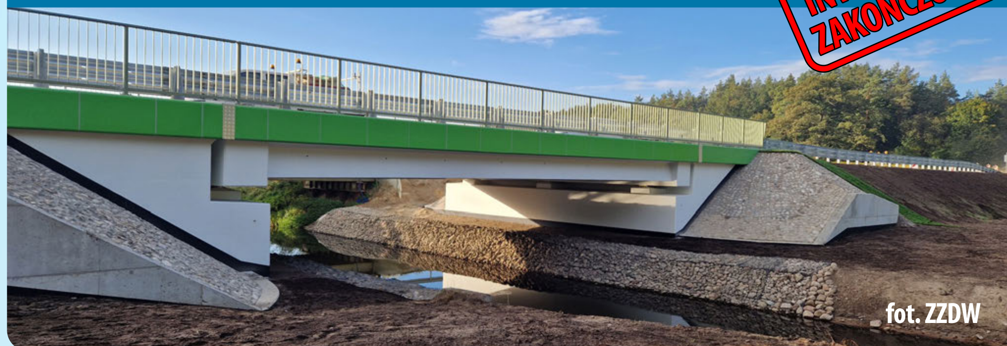
Rozbudowa DW 152 etap II most na rzece Redze
