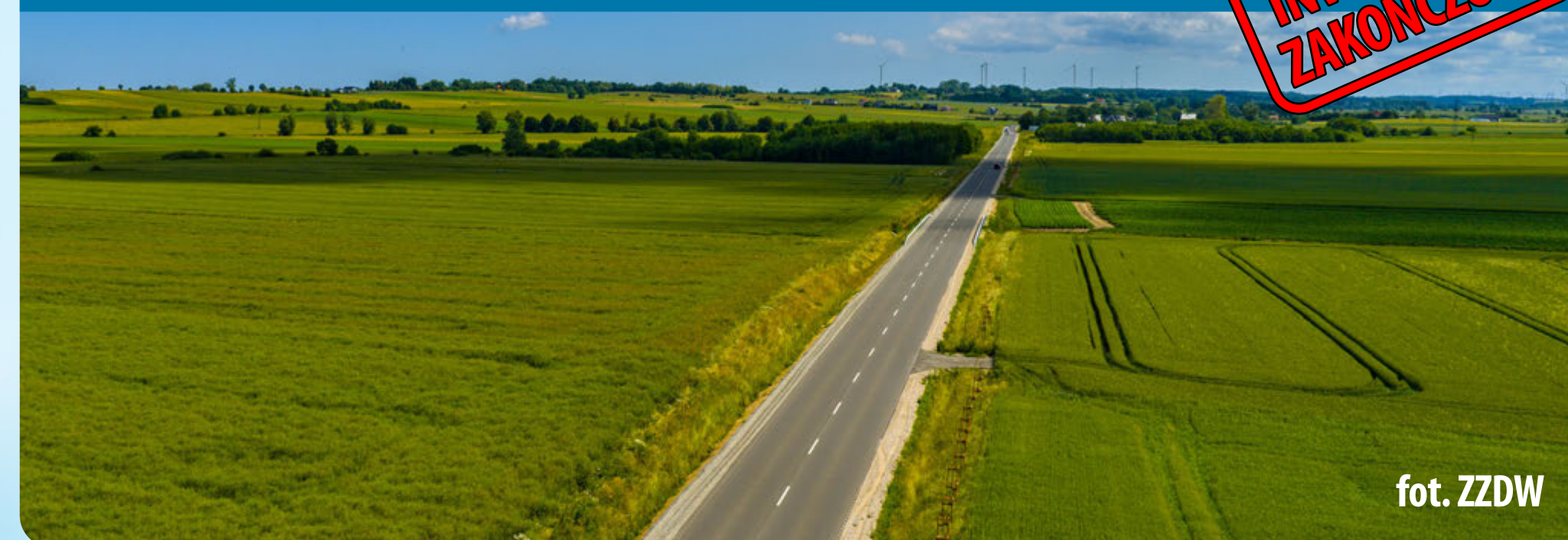
Rozbudowa DW 203 na odcinku Darłowo – granica województwa 22,61 km
